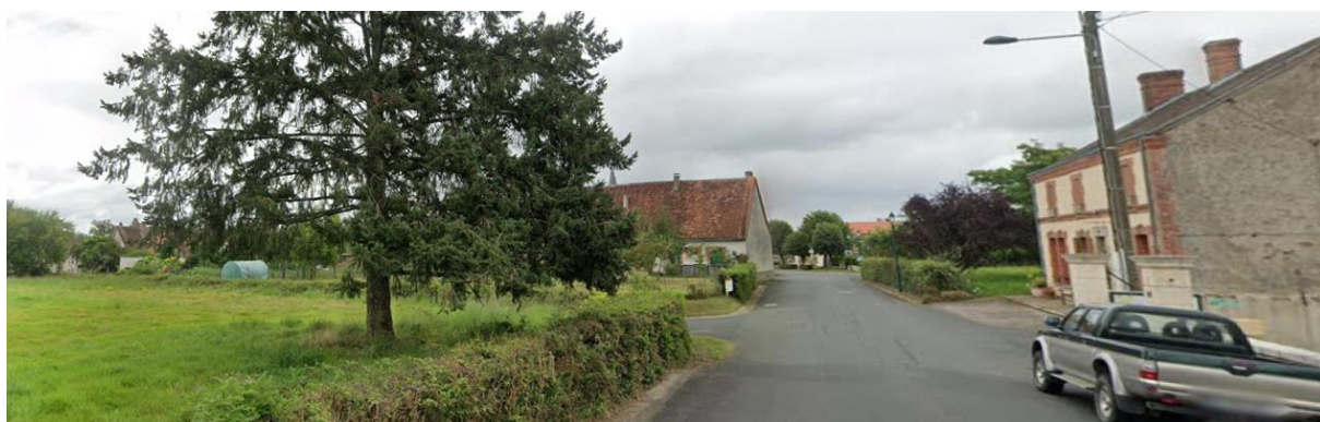
Vue du clocher depuis la D44A, entrée Ouest
