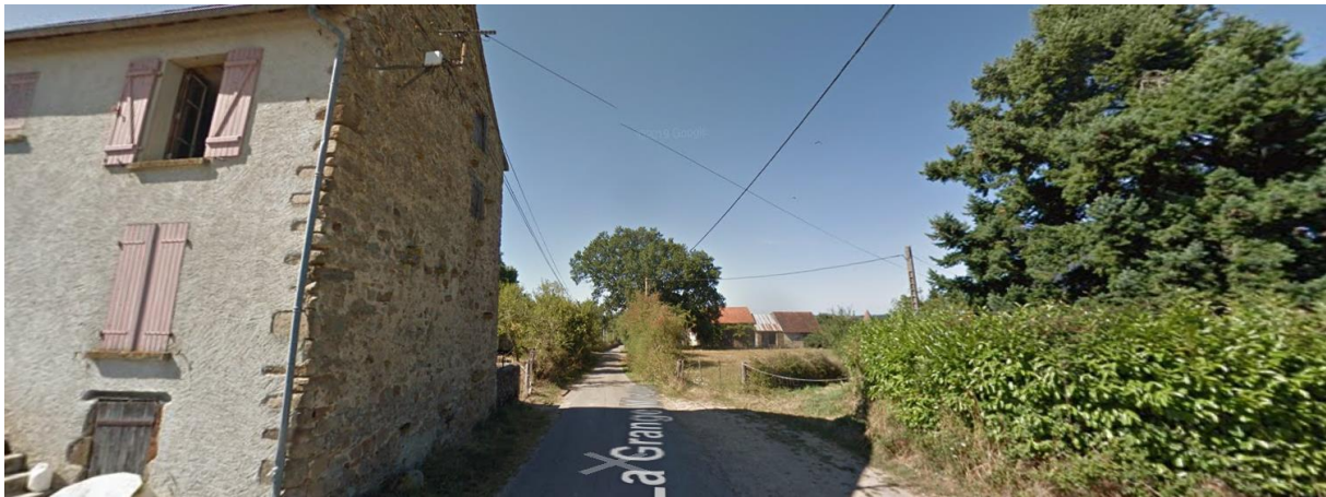
VUE 2 : VUE DE LA MAISON FORTE DEPUIS LA ROUTE A L'EST.
