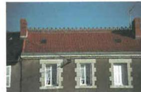
Au XIX<sup>ème</sup> siècle, on voit apparaître avec l'industrialisation, les tuiles mécaniques à emboîtement. Les finitions, faitages et rives étaient souvent décoratifs et les tuiles, ornées de losanges.
