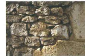
Lorsque des vides subsistent entre les moellons, le maçon les cale avec des éclats triangulaires, appelés "têtes de chat".
