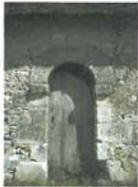
faits de blocs de calcaire taillés ou, plus rarement, de grès. Avant le XIX<sup>ème</sup> siècle, la brique est réservée à la réalisation des conduits de cheminée, des allèges et des fours. Les encadrements de briques, alternés ou non avec du calcaire, se répandent à partir du XIX<sup>ème</sup> siècle, avec le développement des tuileries.
