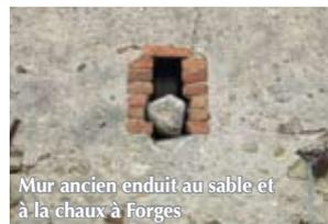
Mur ancien enduit au sable et à la chaux à Forges
