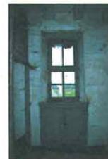
C'est une erreur le plus souvent de les laisser apparents, car la maçonnerie est au même nu que les encadrements.
