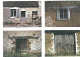
Les proportions de l'ouverture seront, en général, adaptées à l'époque de la construction et à la fonction de l'ouverture : porte d'entrée (L=1xH=2) à (1x2,5); fenêtre environ (1x1) à (1x1,6); porte d'écurie un peu plus haute que large; porte de grange presque carrée.
