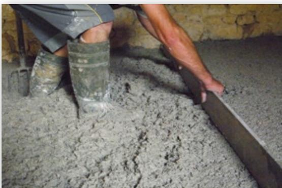
Dalle chaux-chanvre. Pour 25 cm,  $R^* \geq 2,5 \text{ m}^2 \cdot \text{K} / \text{W}$ , en fonction de la chaux utilisée.
