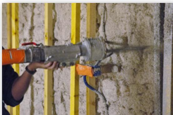
Projection d'un enduit isolant (béton chaux-chanvre).
