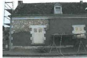
On voit encore trop souvent la première, ou les deux premières couches, réalisées à la chaux grise artificielle. La couche de finition est seule réalisée à la chaux naturelle ou avec un enduit tout prêt de couleur claire. Cette pratique laisse entiers les problèmes de respiration du bâti.
