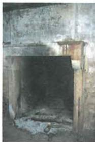
Le manteau s'appuie sur des jambages en pierre taillés dans un calcaire dur. La hotte dépasse à peine de la maçonnerie ou y est encastrée, le foyer est très étroit. L'âtre est toujours situé au niveau du sol.
