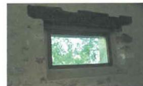
Elle a l'inconvénient d'assombrir les pièces et la texture de l'enduit gratté n'est pas très confortable. Un enduit plein qui est la finition traditionnelle, procure un meilleur confort thermique en limitant l'effet de mur froid.
