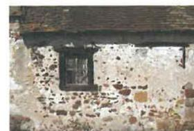
On note encore quelques bâtiments, comme la grange de la Bergelière à Pouligny-Saint-Pierre, construits à partir d'une ossature bois, les poteaux déterminant des travées qui correspondent aux fermes. La maçonnerie de moellons constitue un remplissage entre les poteaux de bois. D'autres bâtiments montrent une variante de ce mode constructif : des poteaux en bois sont encastés dans la maçonnerie, au droit des fermes, pour reprendre la charge de la charpente.
