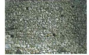
À l'ouest du Parc, de nombreux appareils s'apparentent à la maçonnerie en pierres sèches, au moins pour les parements extérieurs, tant les lits de moellons sont réguliers et les joints les assises, de faible épaisseur. On voit ici les trous de boulon qui marquent la trace de l'échafaudage.
