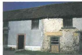
4 - Chaux aérienne, c'est à dire qui fait sa prise à l'air, obtenue par calcination de calcaire pur ou associé à du carbonate de magnésium. On trouve aujourd'hui de la chaux aérienne éteinte pour le bâtiment, en poudre ou en pâte, d'usage facile.
