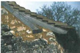
Les coyaux sont des pièces de bois en sifflet, superposées aux chevrons qui relèvent l'égout du toit (L=70 cm à 1m), et éloignent l'eau de pluie de la maçonnerie. Les coyaux présentent de plus un intérêt esthétique. Ils adoucisent la pente de la toiture et contribuent à l'élégance des bâtiments, surtout lorsque les toits sont d'un volume impo-
