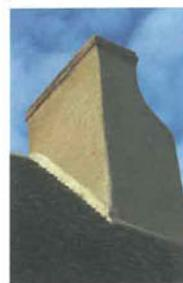
Si le conduit n'est pas encasté dans le mur, la souche est décalée de la largeur du mur et, quelquefois, soutenue par un petit contrefort.
