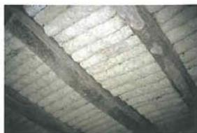
Les "fusées" sont faites de petits bâtons de chêne ou de châtaignier, refendus en forme de navette, d'où leur nom. On y enrôle de la paille ou du foin puis on les trempe dans la terre argileuse. Les fusées sont posées côte à côte au-dessus des solives et recouvertes par une couche de torchis (terre et paille mêlés) pour égaliser la surface.
