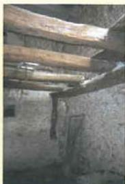
Jusqu'au XVII<sup>ème</sup> siècle, un système intermédiaire dessine des fermes par des pièces de bois de plus forte section. Le poinçon repose sur une solive d'une section plus importante, formant entrait. Deux demi-faux entraits sont assemblés au poinçon et aux arbalétriers. L'unique panne intermédiaire est posée dans une encoche de l'entrait et non sur l'arbalétrier comme aujourd'hui.
