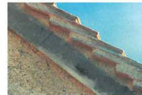
Attention à ne pas coffrer le bord des tuiles pour faire le scellement. La finition est plus jolie lorsque la tranche des tuiles est visible.
