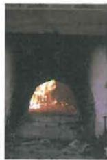
La bouche du four en demi-lune est en briques le plus souvent ou en pierre. Elle est fermée par une simple plaque en tôle, le "bouche-four". La pièce d'appui à l'entrée du four s'appelle l'autel.
