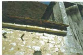
Lorsque la couverture affleure la faite du mur gouttereau, les dernières rangées de tuiles sont légèrement relevées pour éloigner l'eau, par l'interposition d'un doublets ; deux rangs de tuiles posées à plat en quinconce sur le faite du mur. Cette finition a aussi un effet décoratif.
