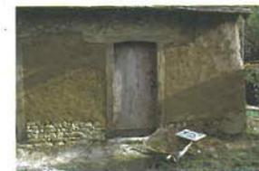
La bauge s'appuie sur un mur bahut de 50 cm de haut minimum, qui la met à l'abri de l'humidité du sol.
